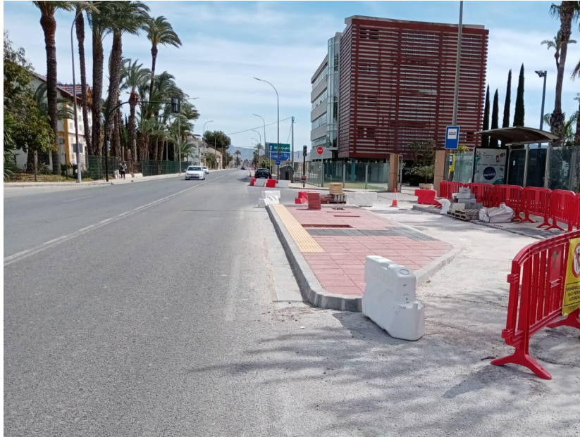
Isleta en la Avenida de Alcantarilla, día 08-04-23
